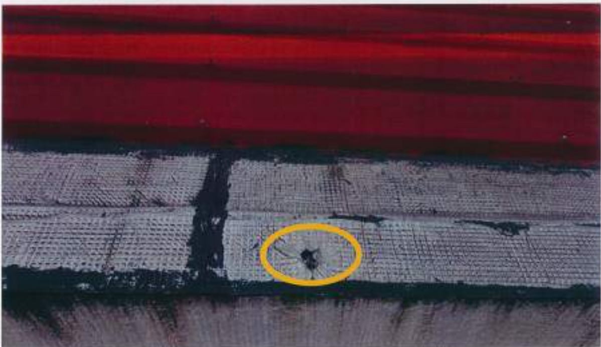
Σχίσσιμο ασφαλτικών μεμβρανών στους αρμούς μεταξύ των τμημάτων της στέγης
