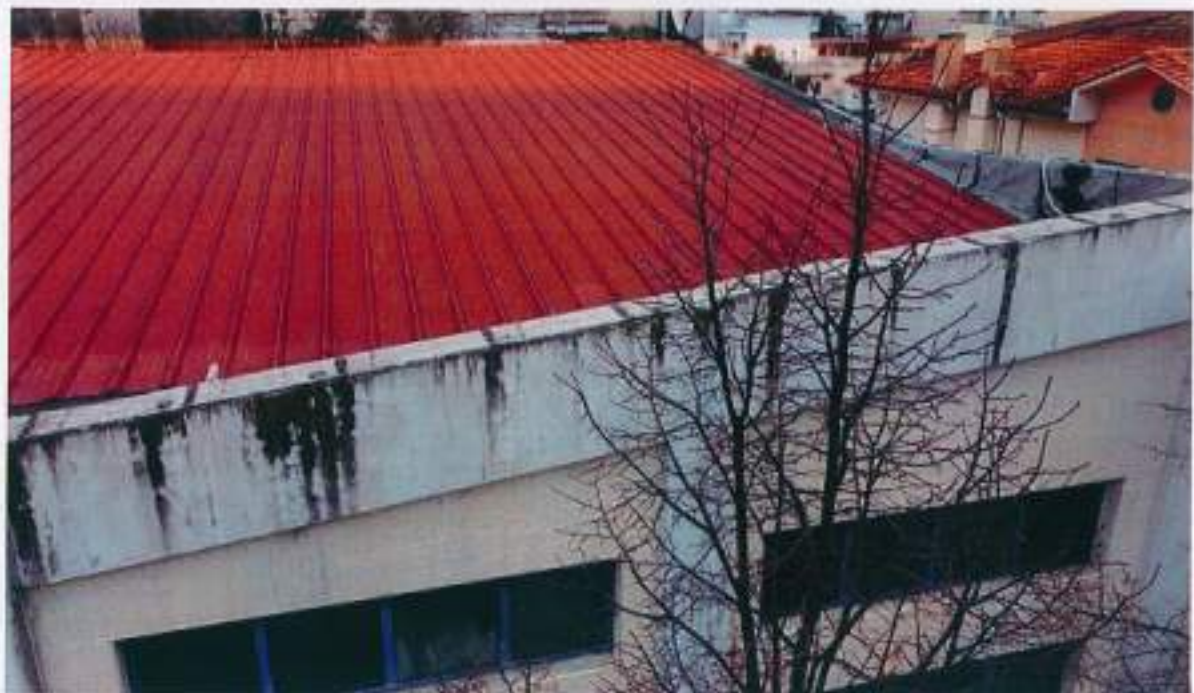
Ανοιχτοί αρμοί, σκισμένες μεμβράνες, έλλειψη περιμετρικού ειδικού τεμαχίου
